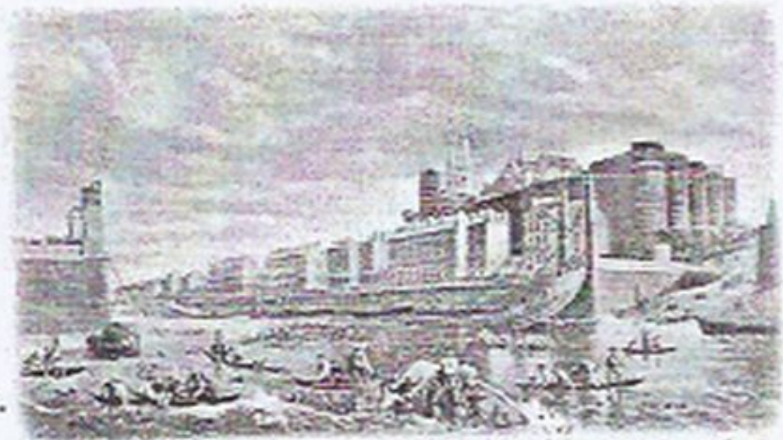
Catastrophe du Pont suspendu, effondrement du Pont de la Basse-Chaine le 14 avril 1850 (de l'œuvre d'Angers)
